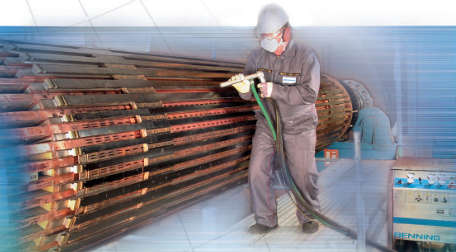
Abb.: Anwendung des Trockenschneestahlverfahrens bei einem Induktor im Kraftwerk
