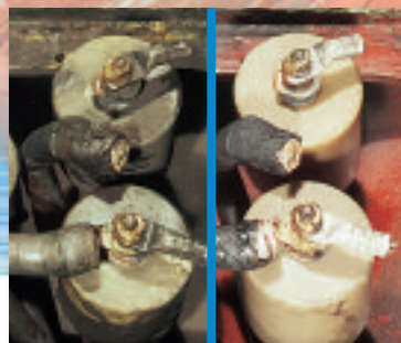
Abb. 5: Vergleich vor/nach dem Trockenschneestrahlen
