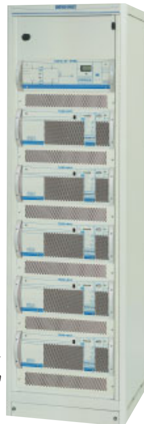
Obr. 5: Střídačový systém 5 x 2,5 kVA s EUE
